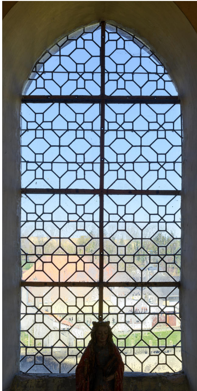
Verrière (baie 9) : verrière à borne.
