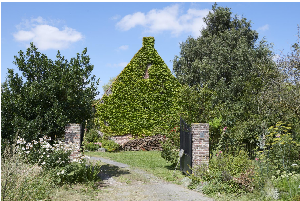
Portail d'accès à la chaumière. Grange en arrière plan.
