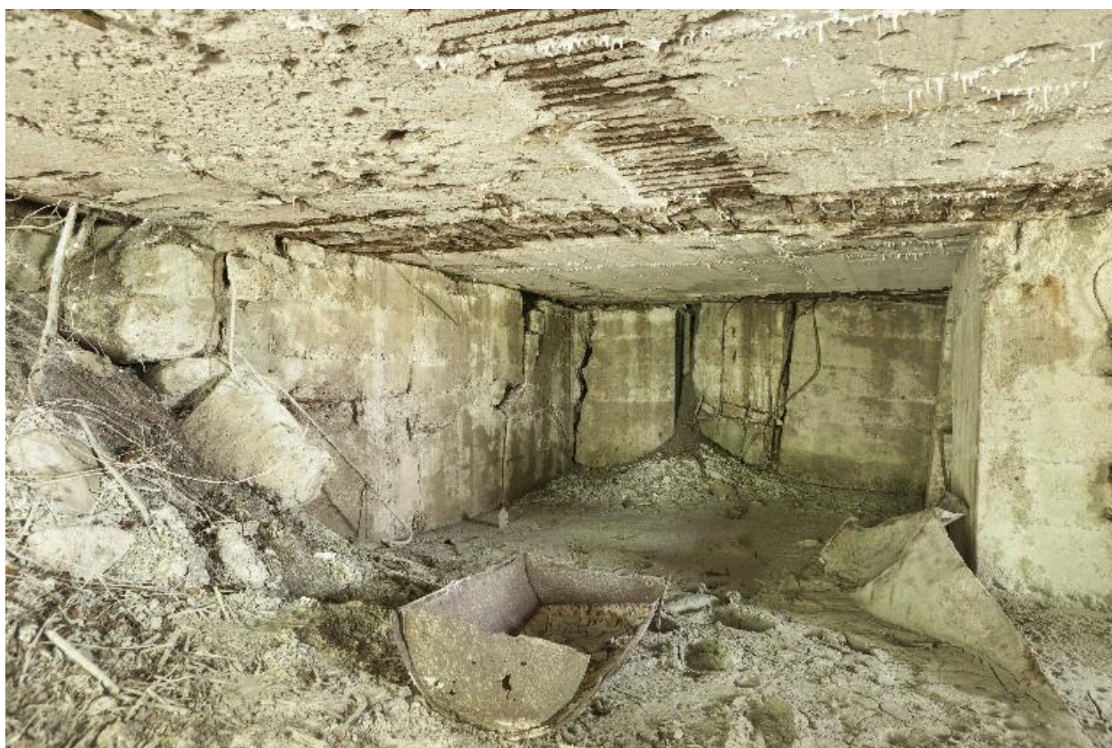
Vue intérieure vers l'extrémité nord de l'édifice
