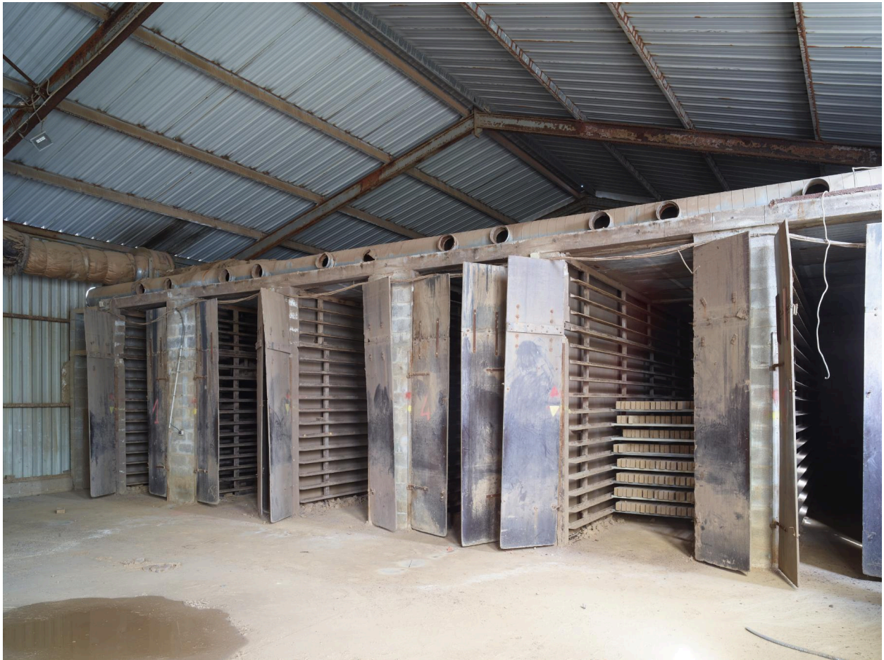
Hangar des séchoirs (étuves). Claies de séchage.
