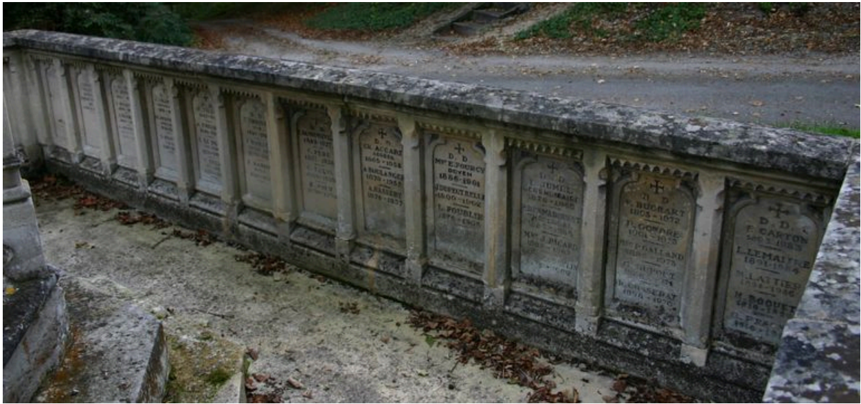
Détail du mur-pâlis intérieur.
