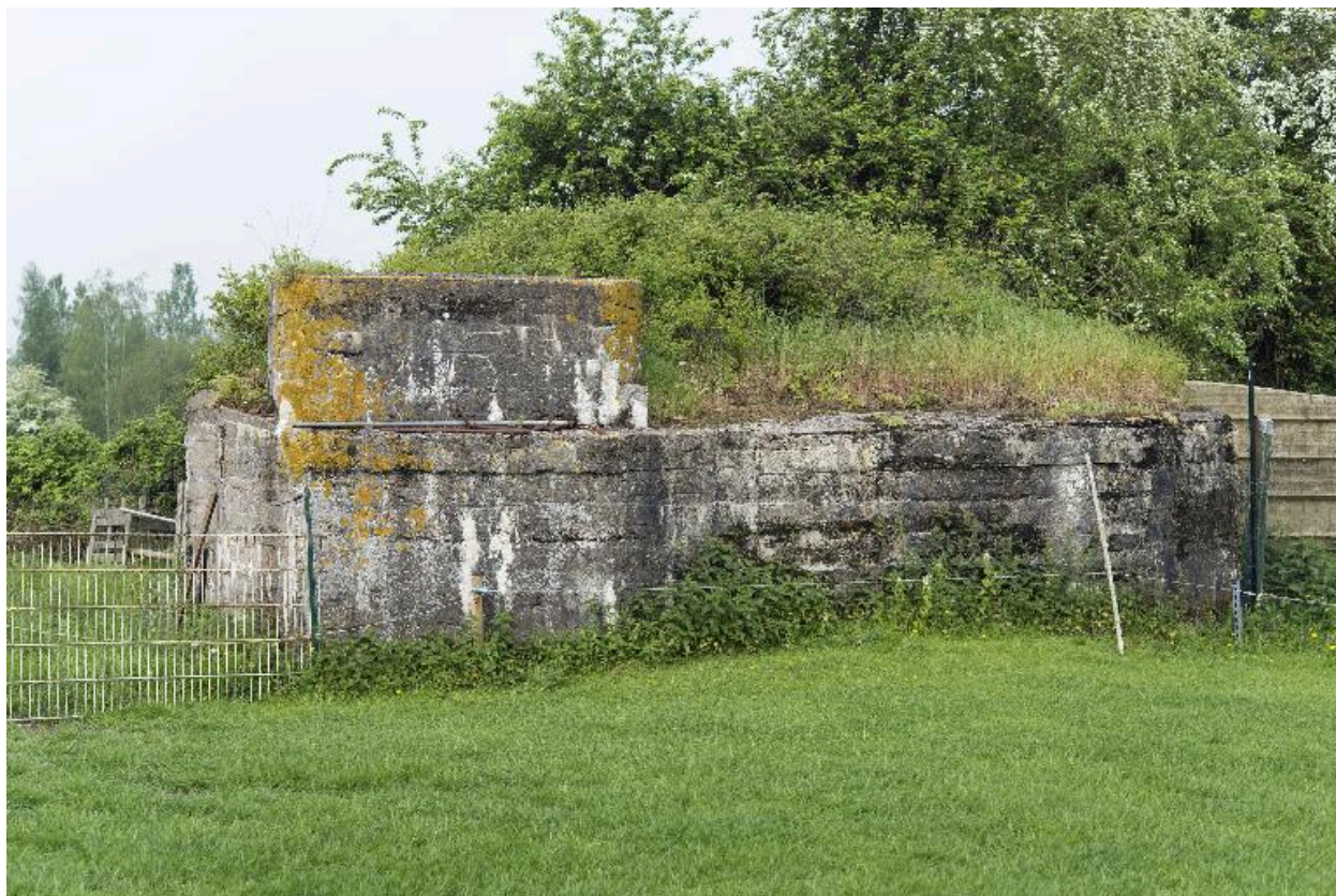
Vue latérale, vers l'ouest
