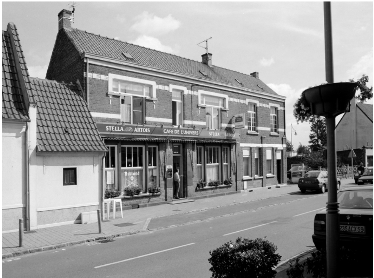
Vue générale d'un café construit pendant l'entre-Deux-Guerres, rue Ricquier.
