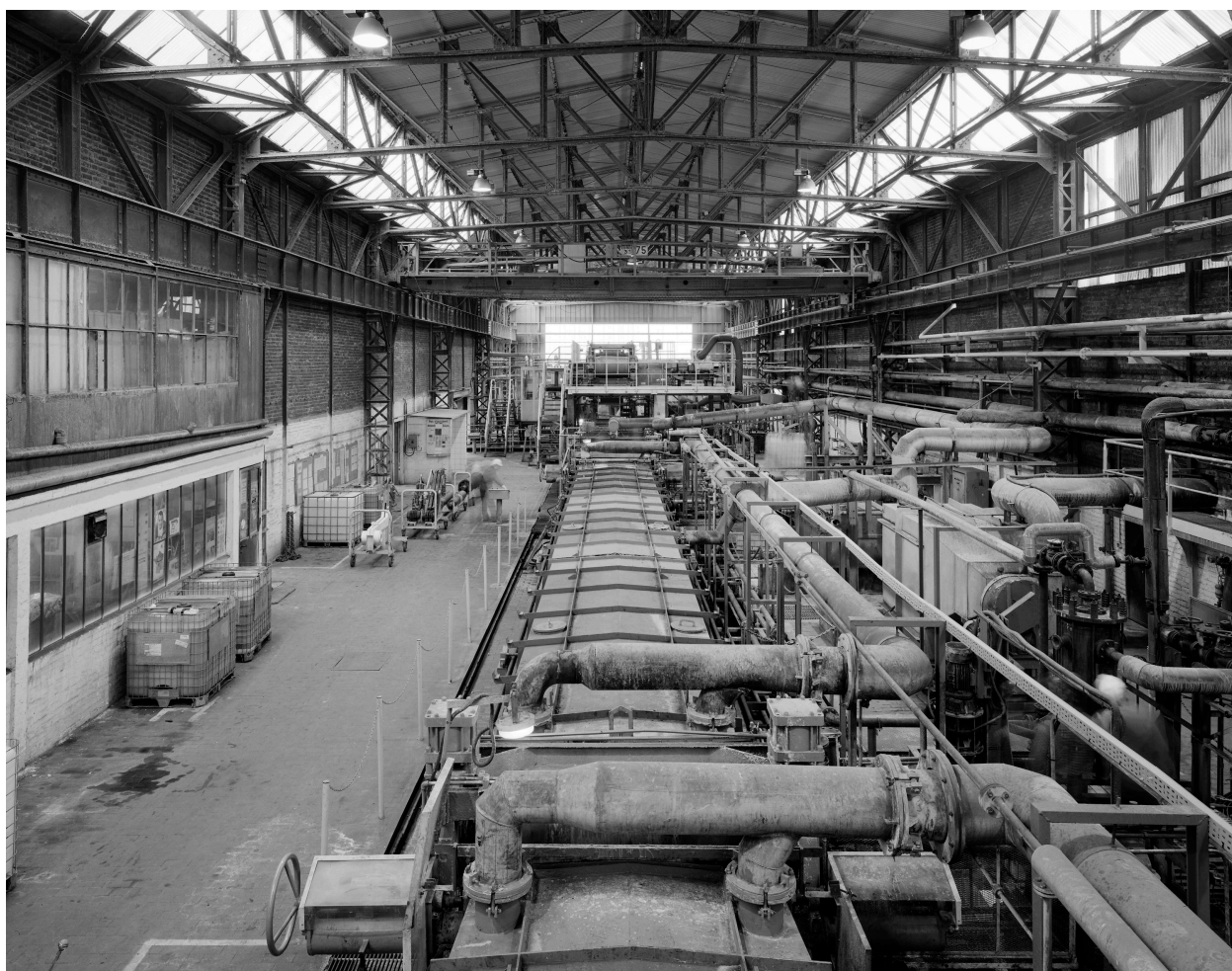
Vue générale du bassin de traitement.
