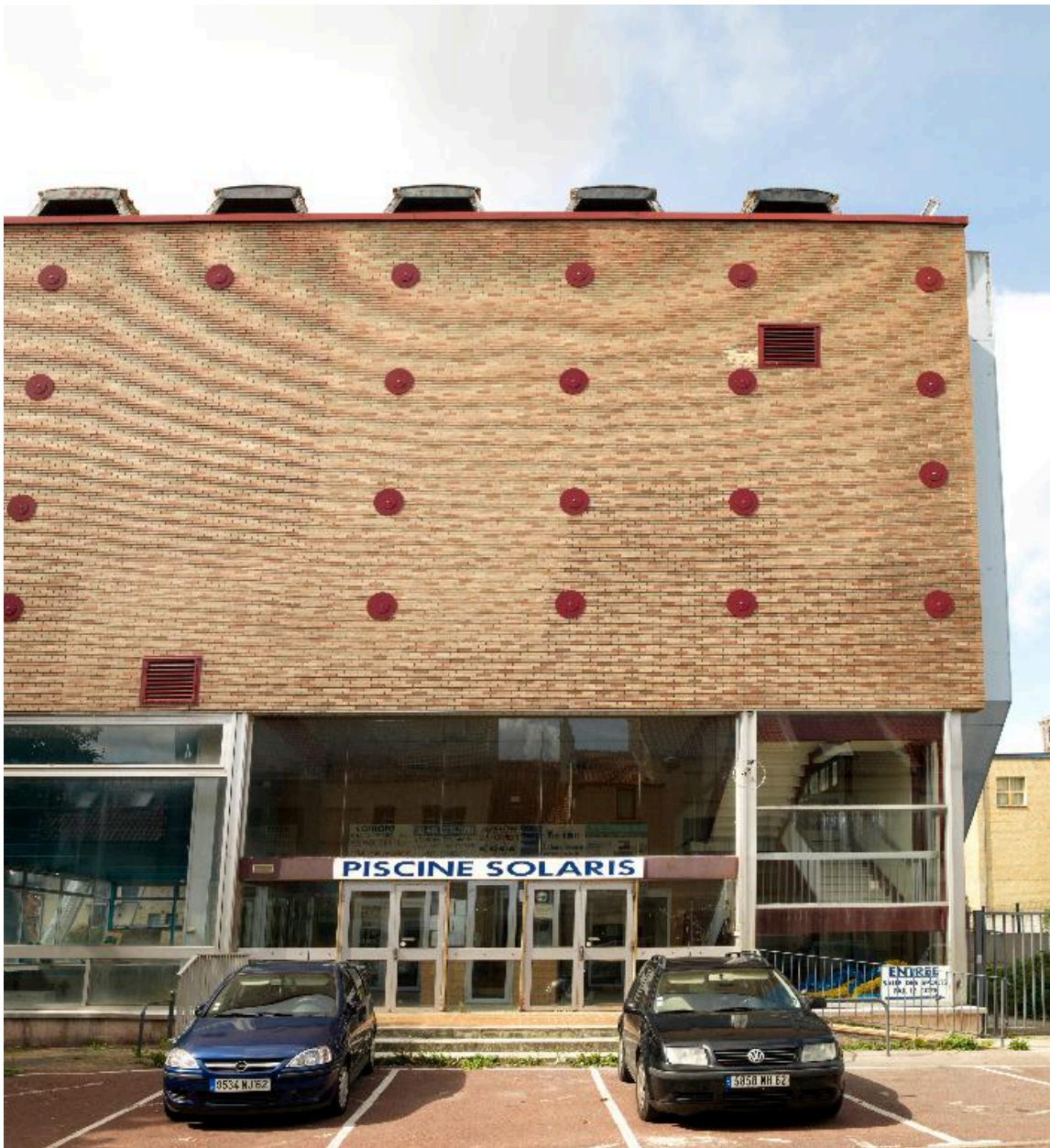
Entrée de la piscine.
