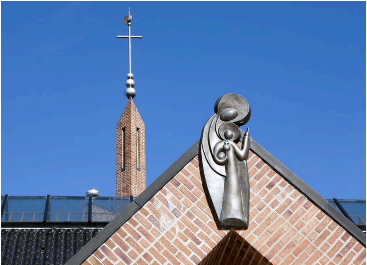
Partie supérieure de l'élévation antérieure.
