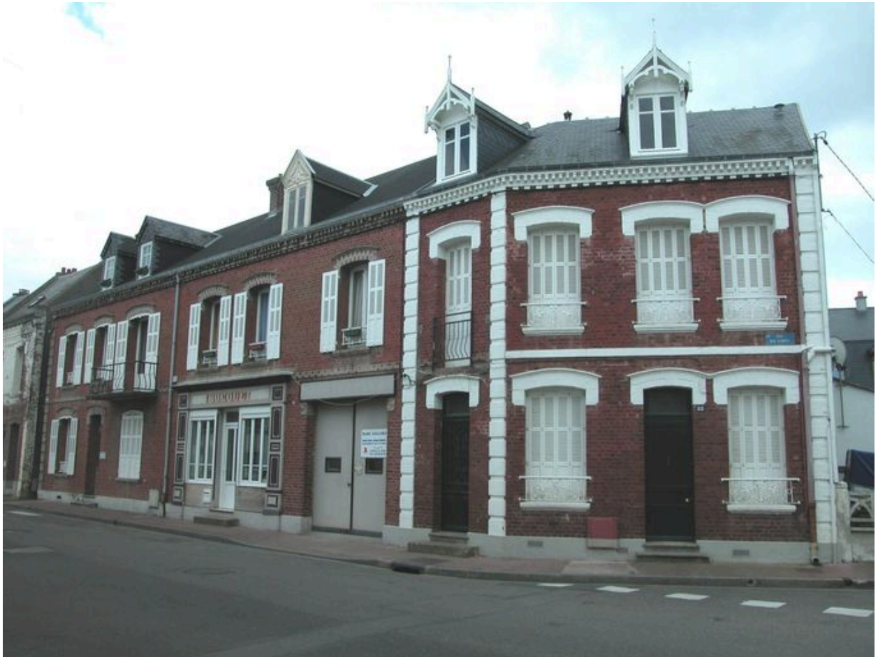
Vue d'ensemble des trois logements accolés.
