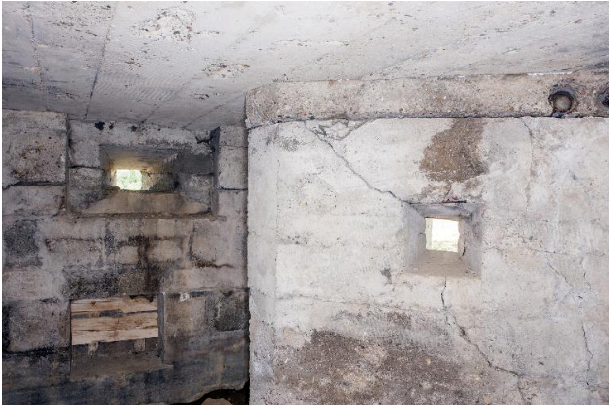
Entrée en chicane ouest et son créneaux de tir. A gauche, ouverture de tir de l'élévation ouest et sa niche à munitions (dessous)
