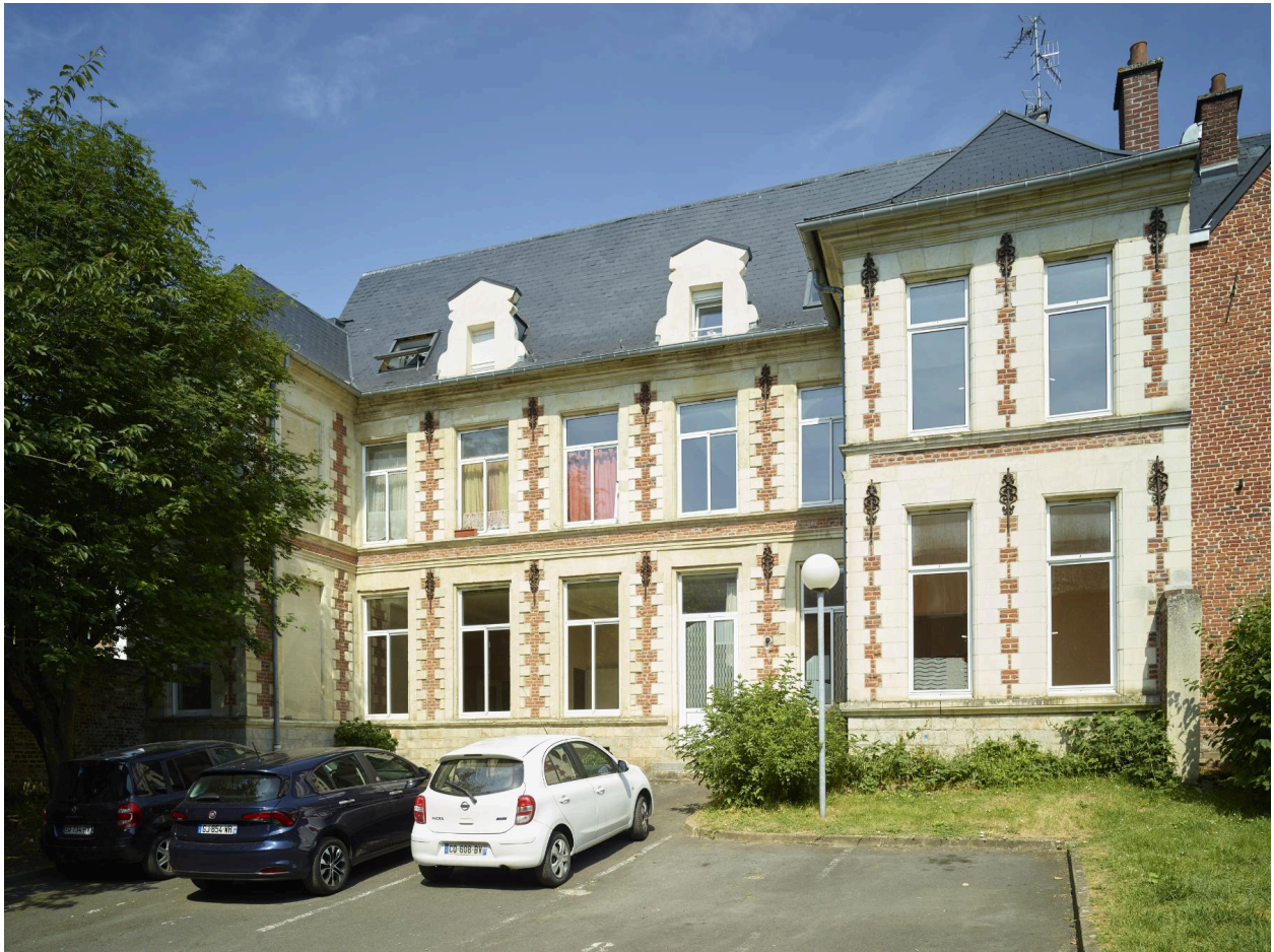
Façade arrière du 11 rue Théau. Vue de face depuis la rue Brancion.
