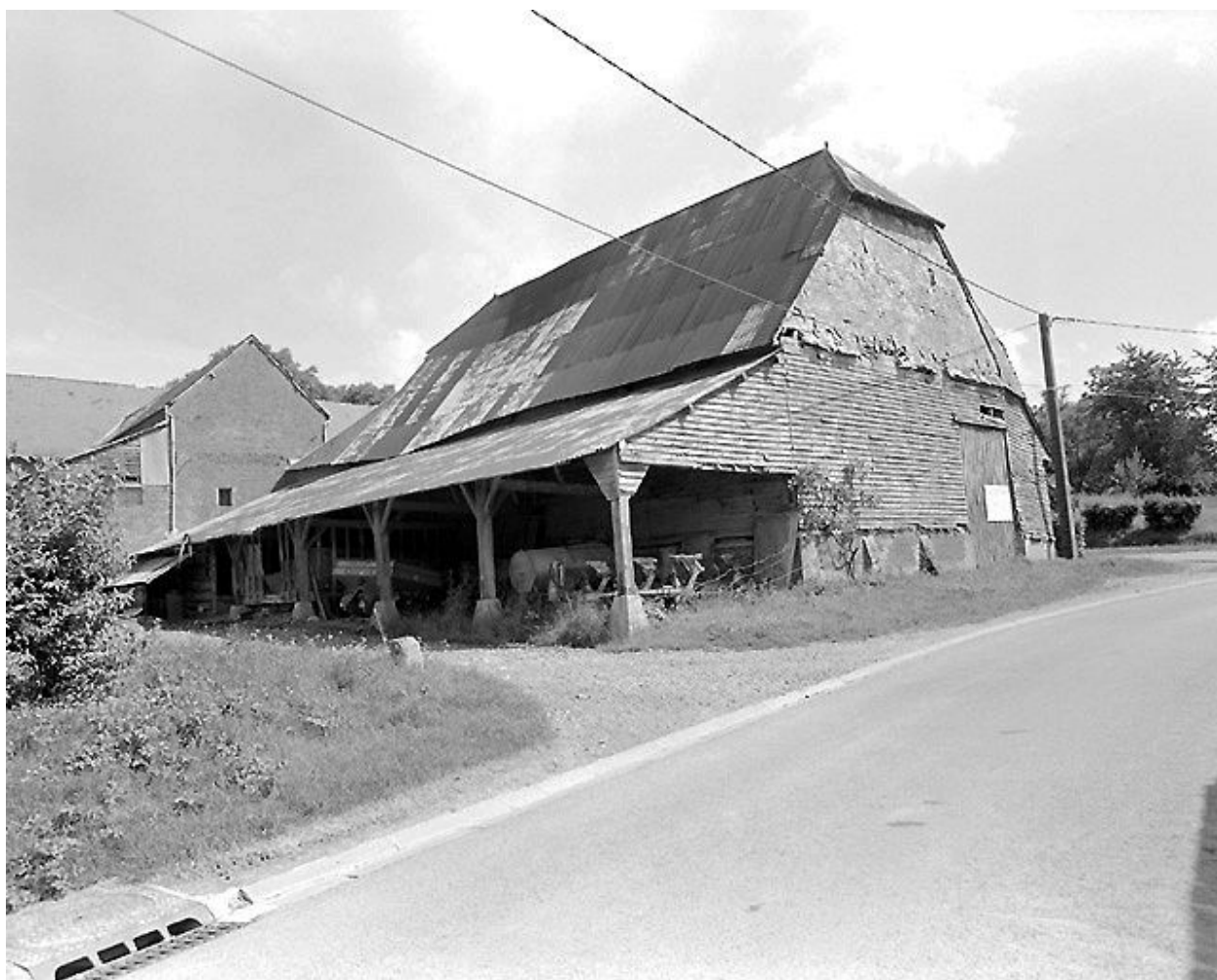
Grange depuis le sud-ouest.
