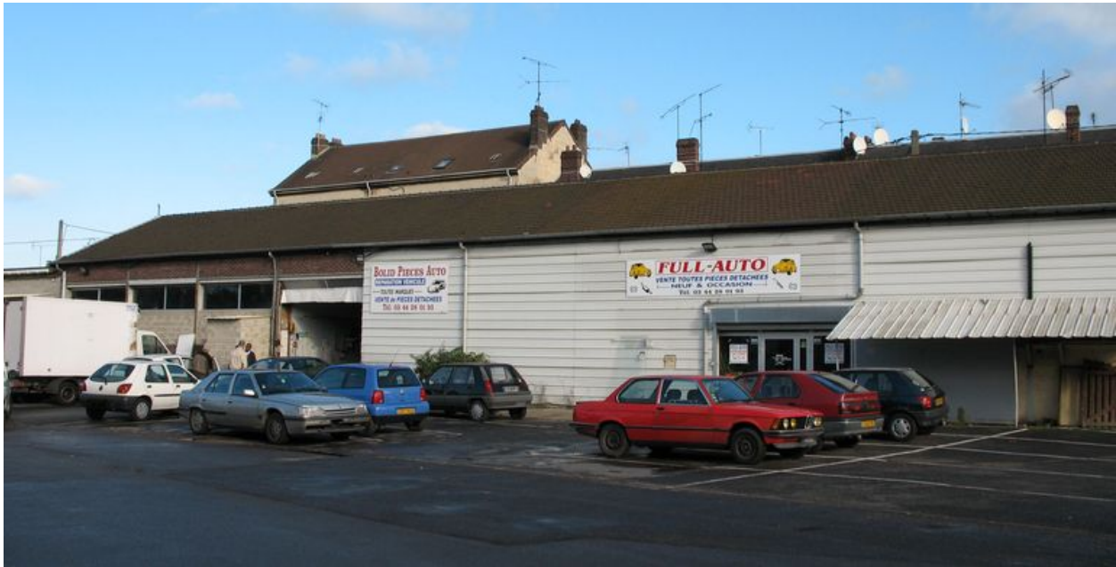
Les anciens magasins du matériel des établissements Daydé.
