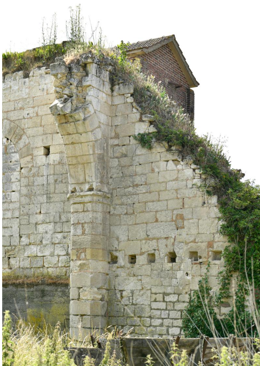
Mur intérieur du pignon sud, côté ouest.
