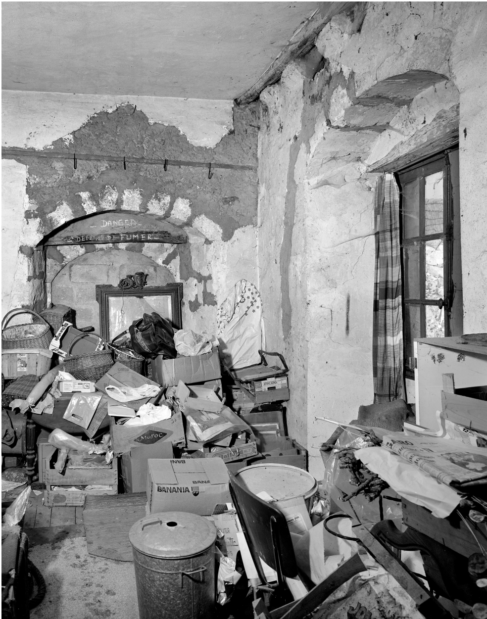
Vue de la pièce du premier étage avec les deux baies cintrées.
