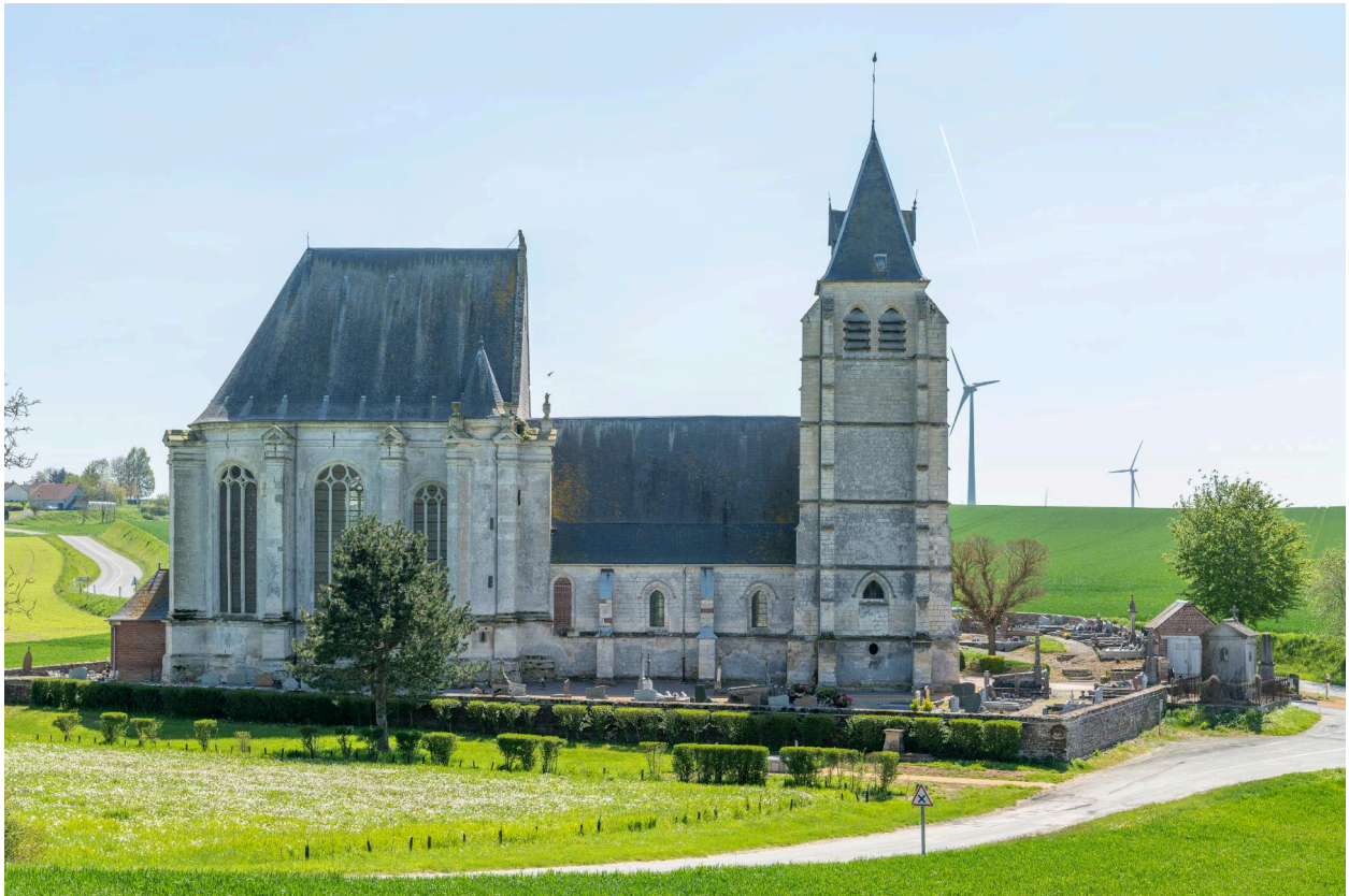
Vue générale de l'élévation nord.
