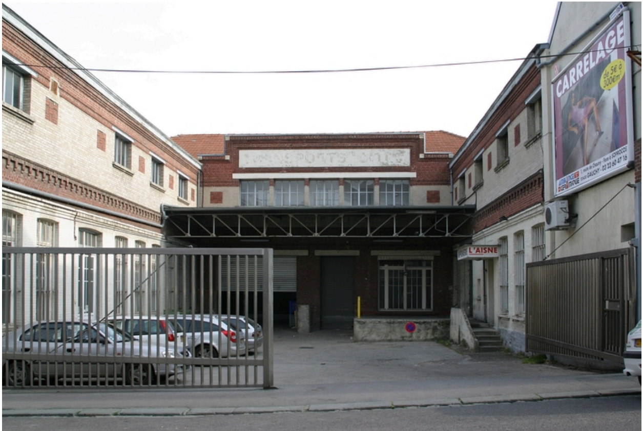
Cour de l'usine, rue Jean-de-Caulaincourt.
