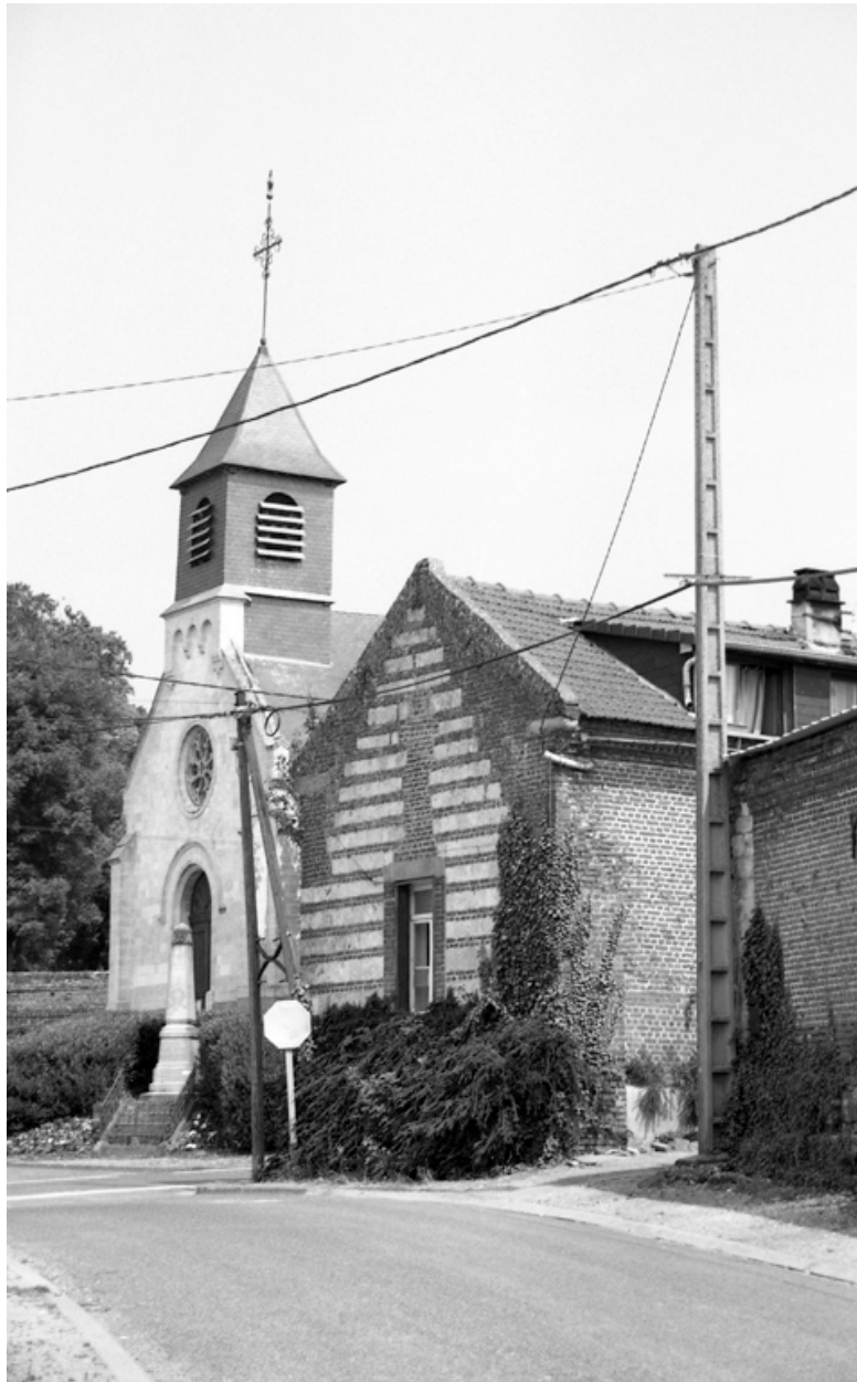
Beaucourt-sur-l'Hallue, ferme, 1 rue du Vieux-Cimetière.
