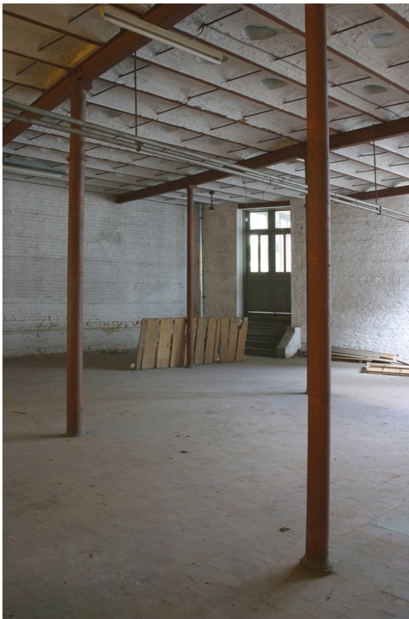
Rez-de-chaussée de l'atelier de 1900.
