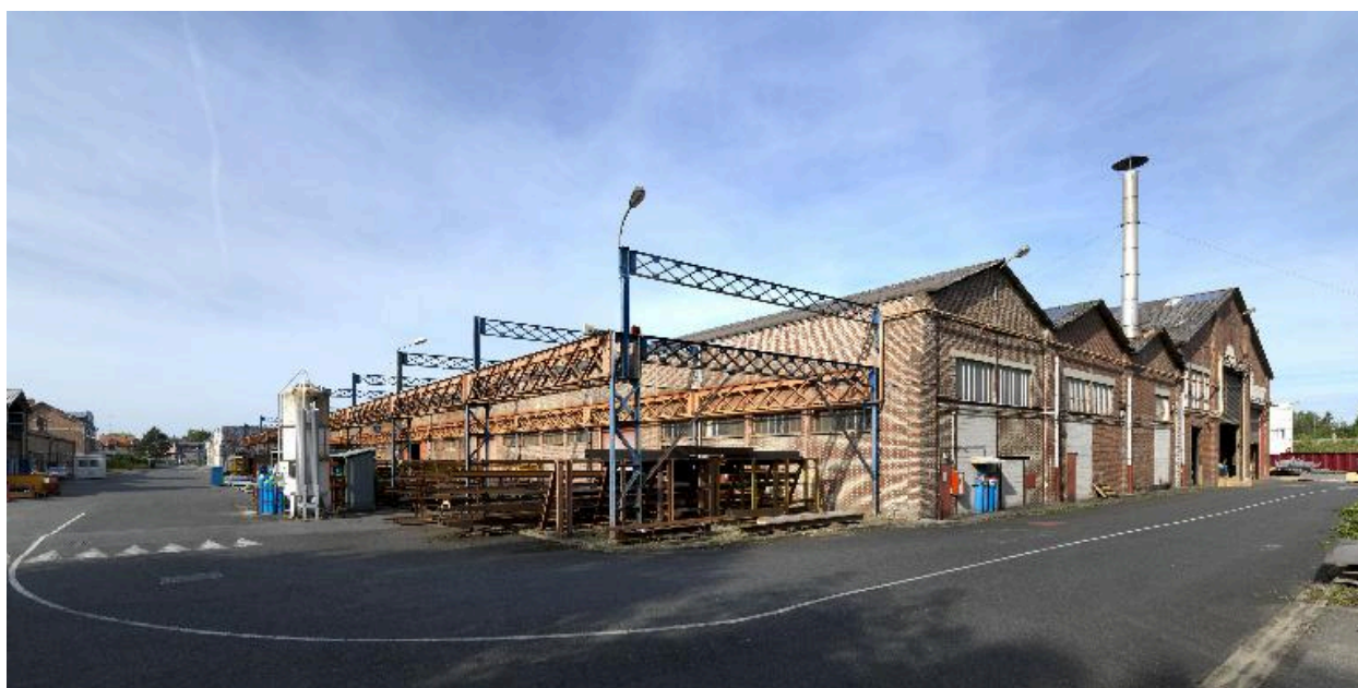
Atelier de chaudronnerie précédé du parc de matières premières, vue d'ensemble sud-est.
