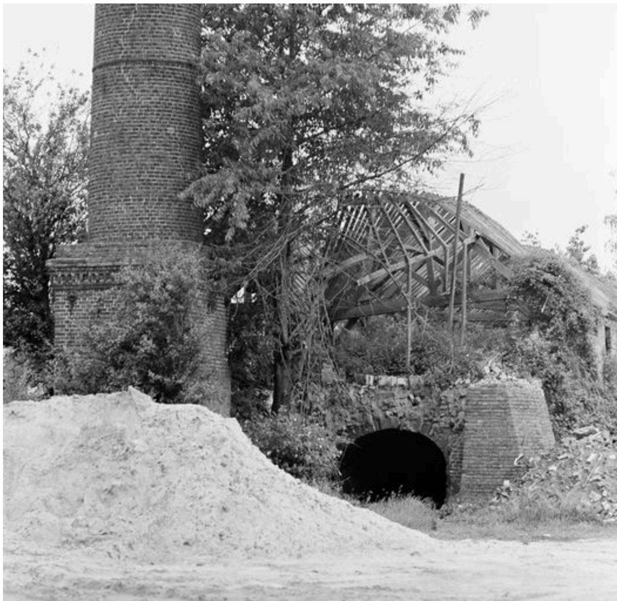
Four industriel Hoffmann et socle de la cheminée d'usine, flanc sud.
