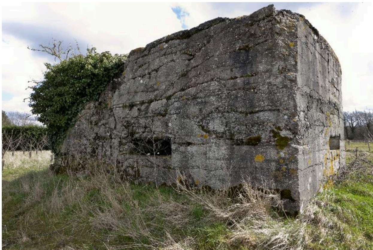
Vue vers le sud-est
