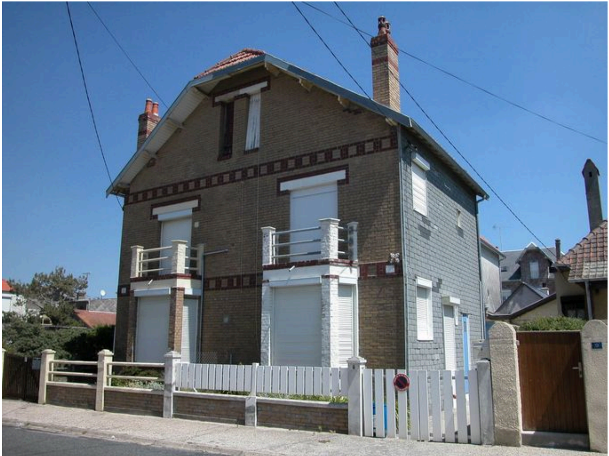
Villa à deux logements accolés (5 et 7 rue Joffre).
