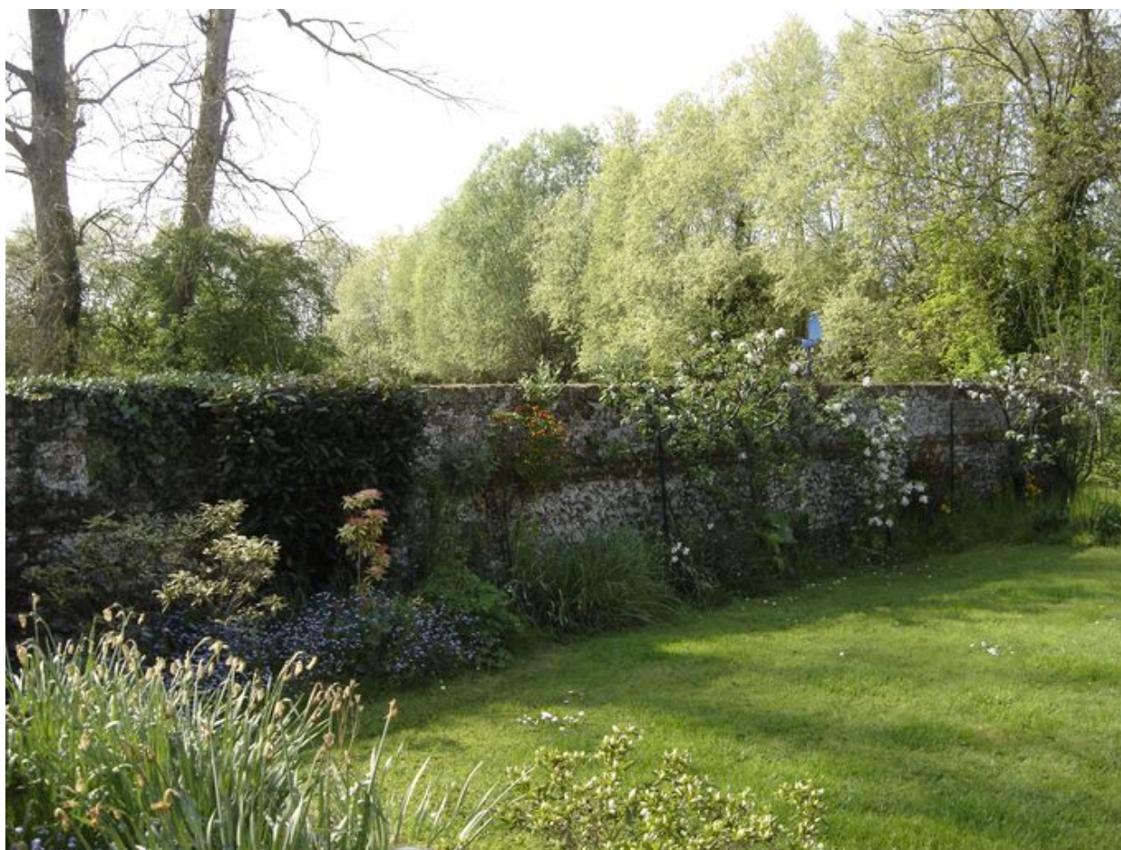
Vue d'une partie du mur de clôture du jardin.
