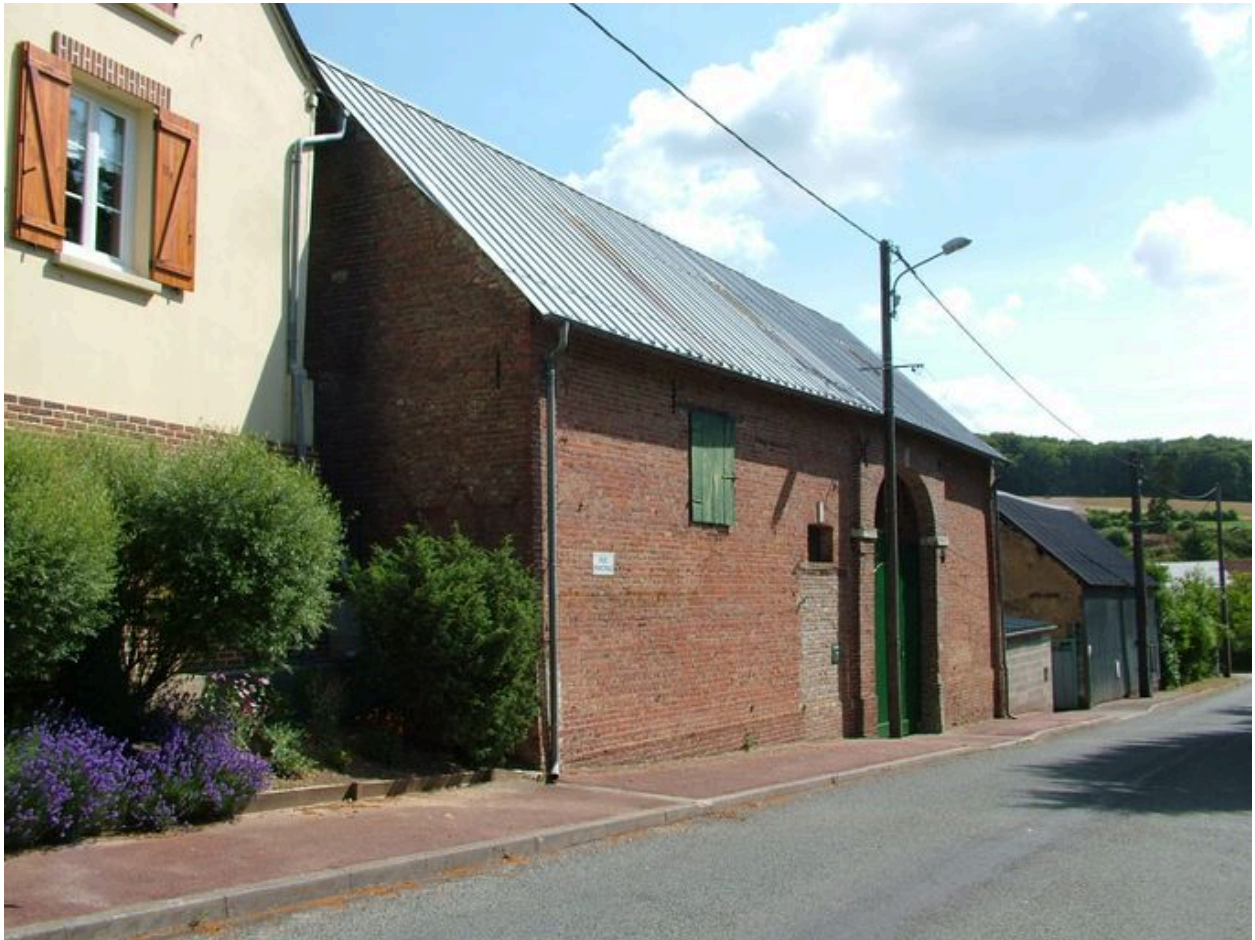
Vue générale depuis la rue, en amont.
