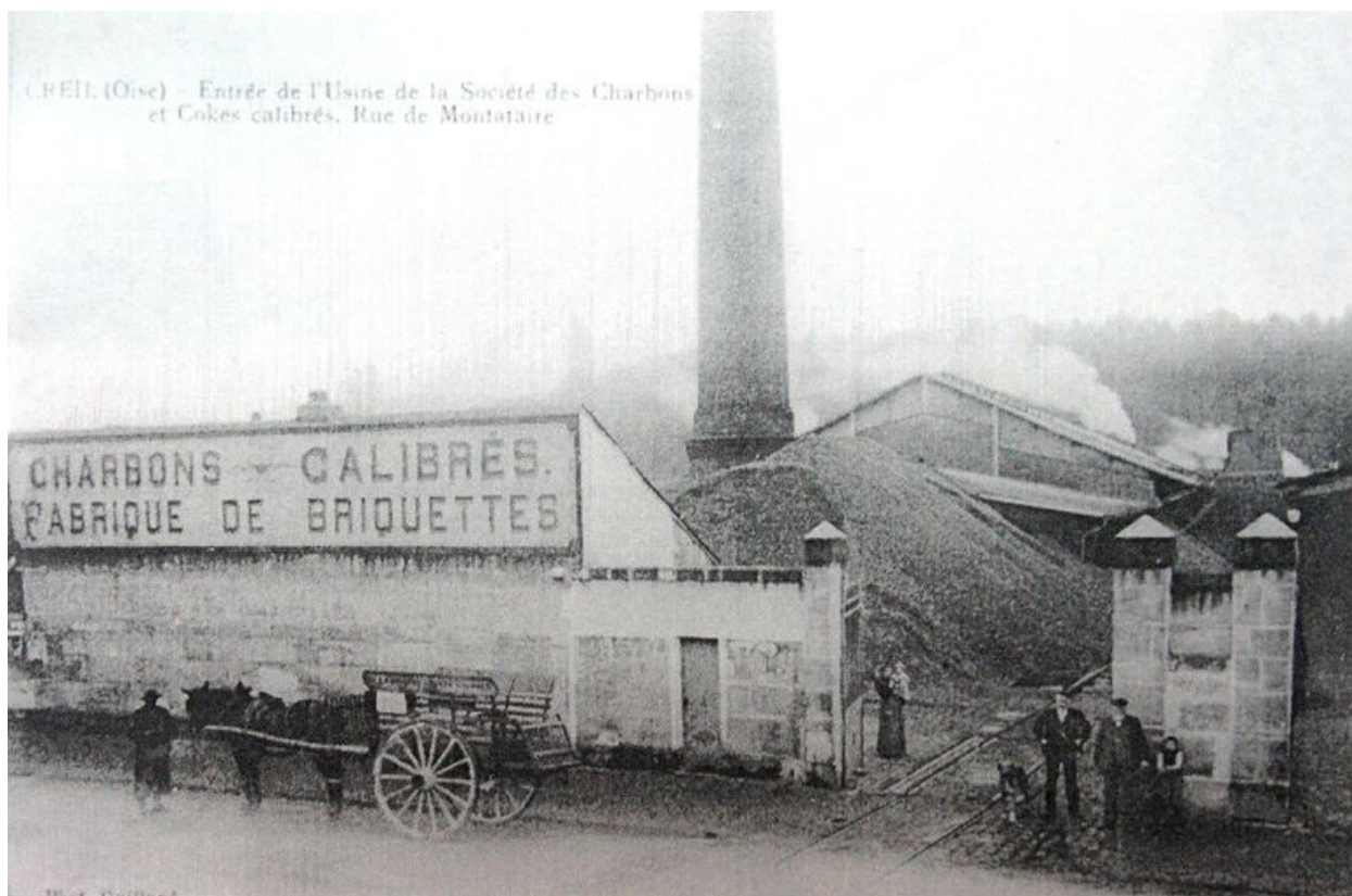
La fabrique de briquettes et de boulets de charbon au début du 20e siècle (AC Creil).
