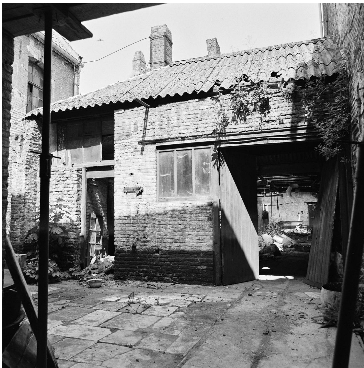
Atelier de fabrication. Vue générale sur cour.
