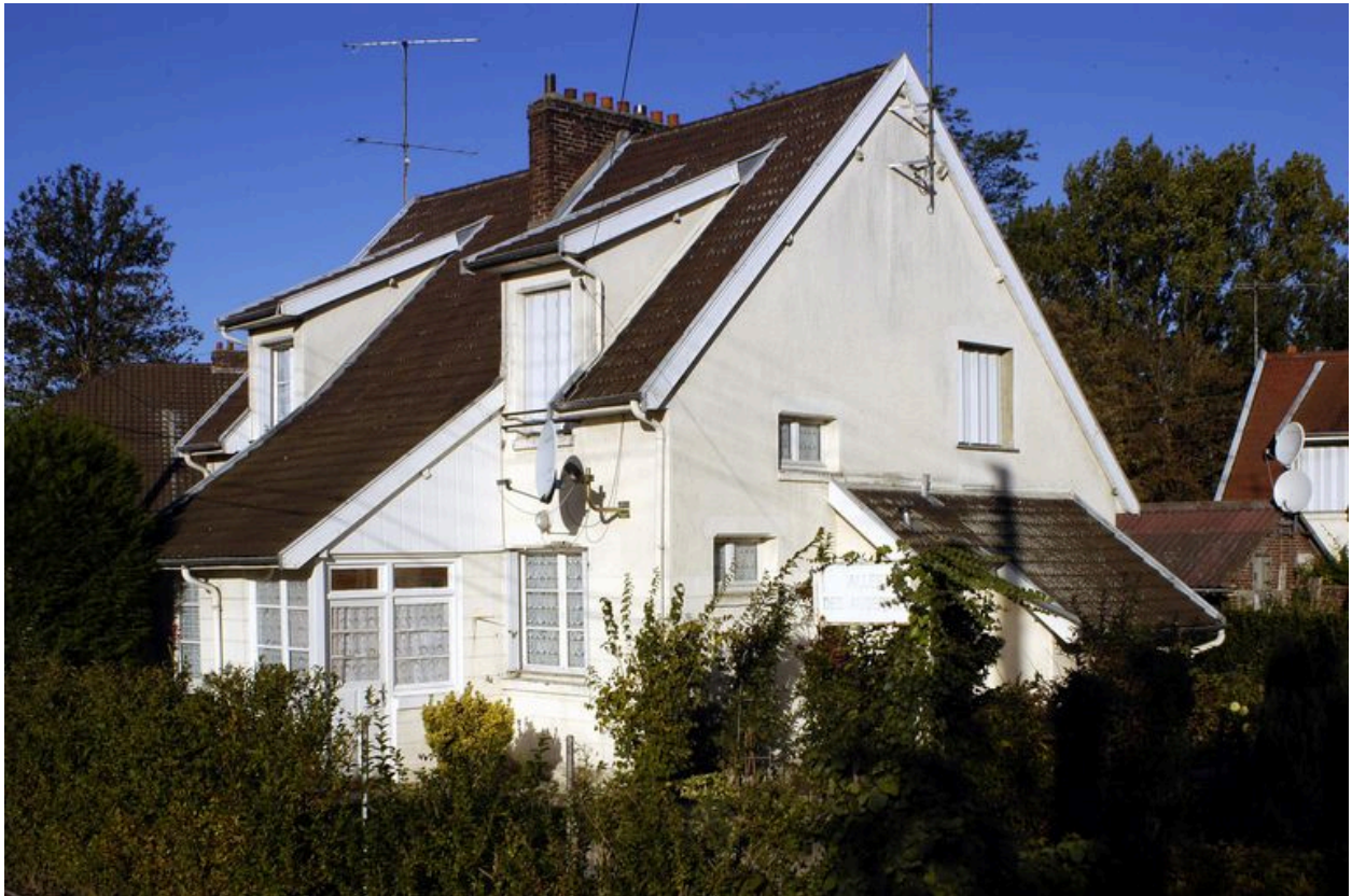
Maison à deux unités d'habitation (2 logements de 4 pièces), 8 et 10 allée des Aubépines. Vue prise en 2004 avant restauration.
