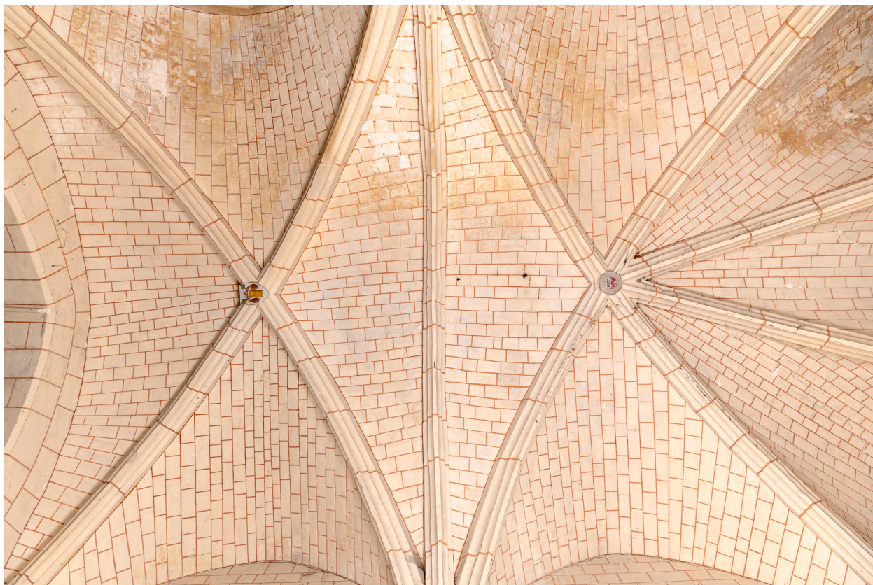
Voûte de la chapelle de la Madeleine.
