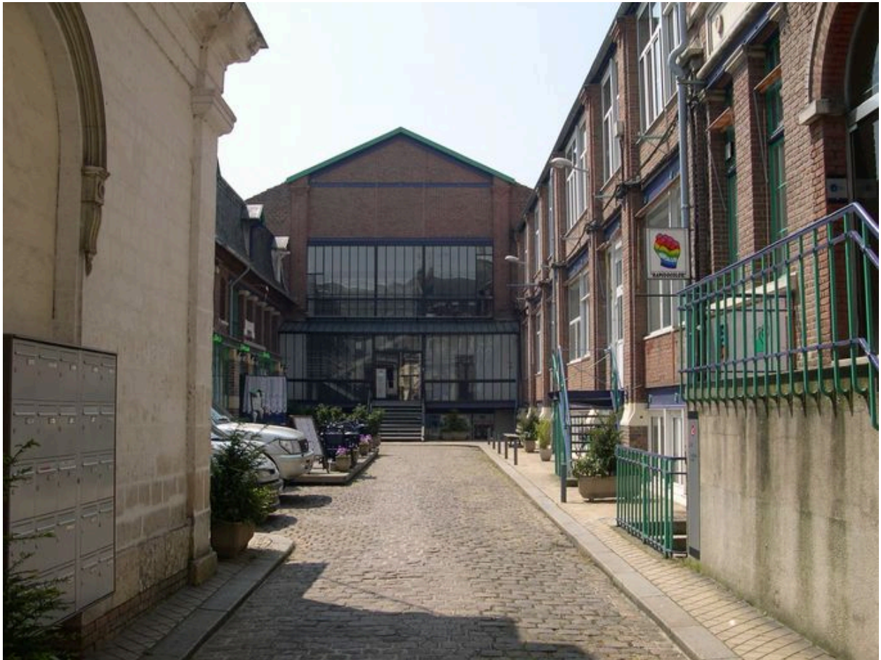
Vue de la cour intérieure.
