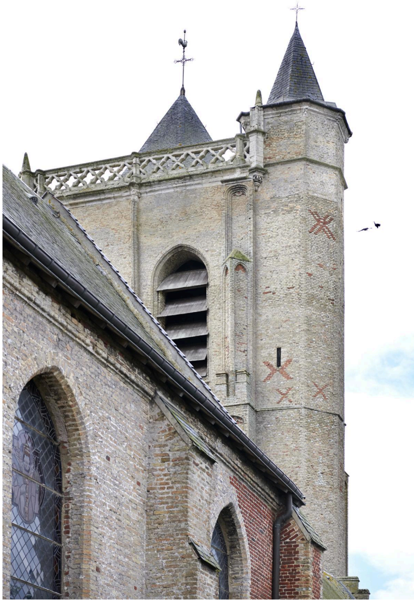
Vue de l'arrière du clocher depuis le nord.
