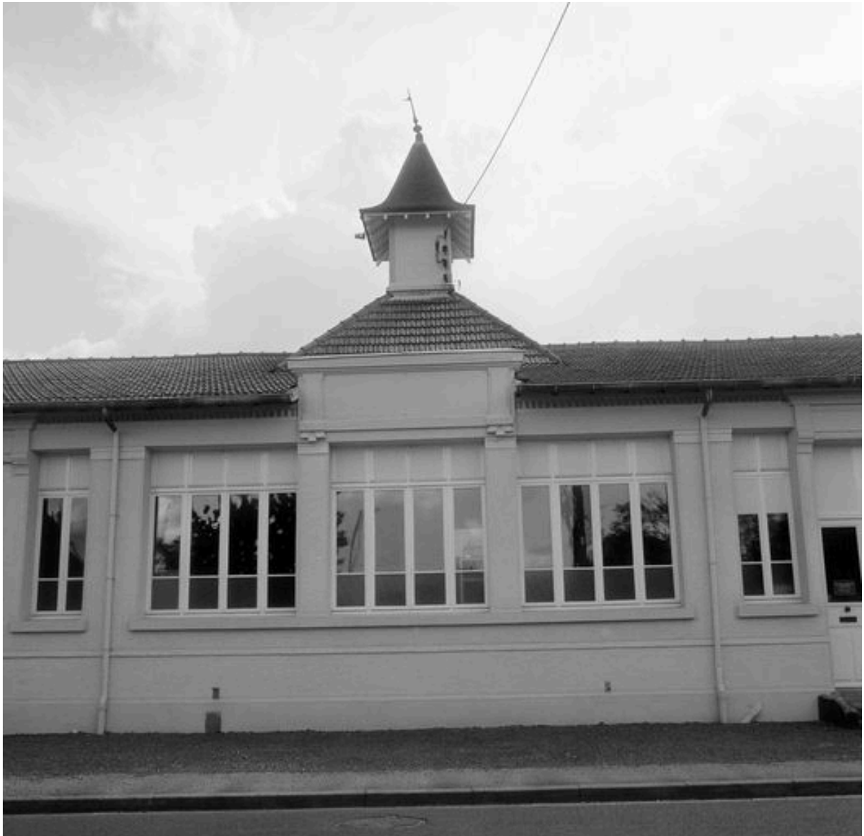
Ecole : détail des travées centrales avec clocheton.
