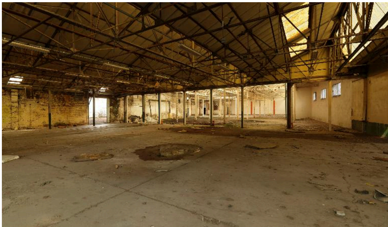
Vue intérieure des anciens ateliers de préparation.
