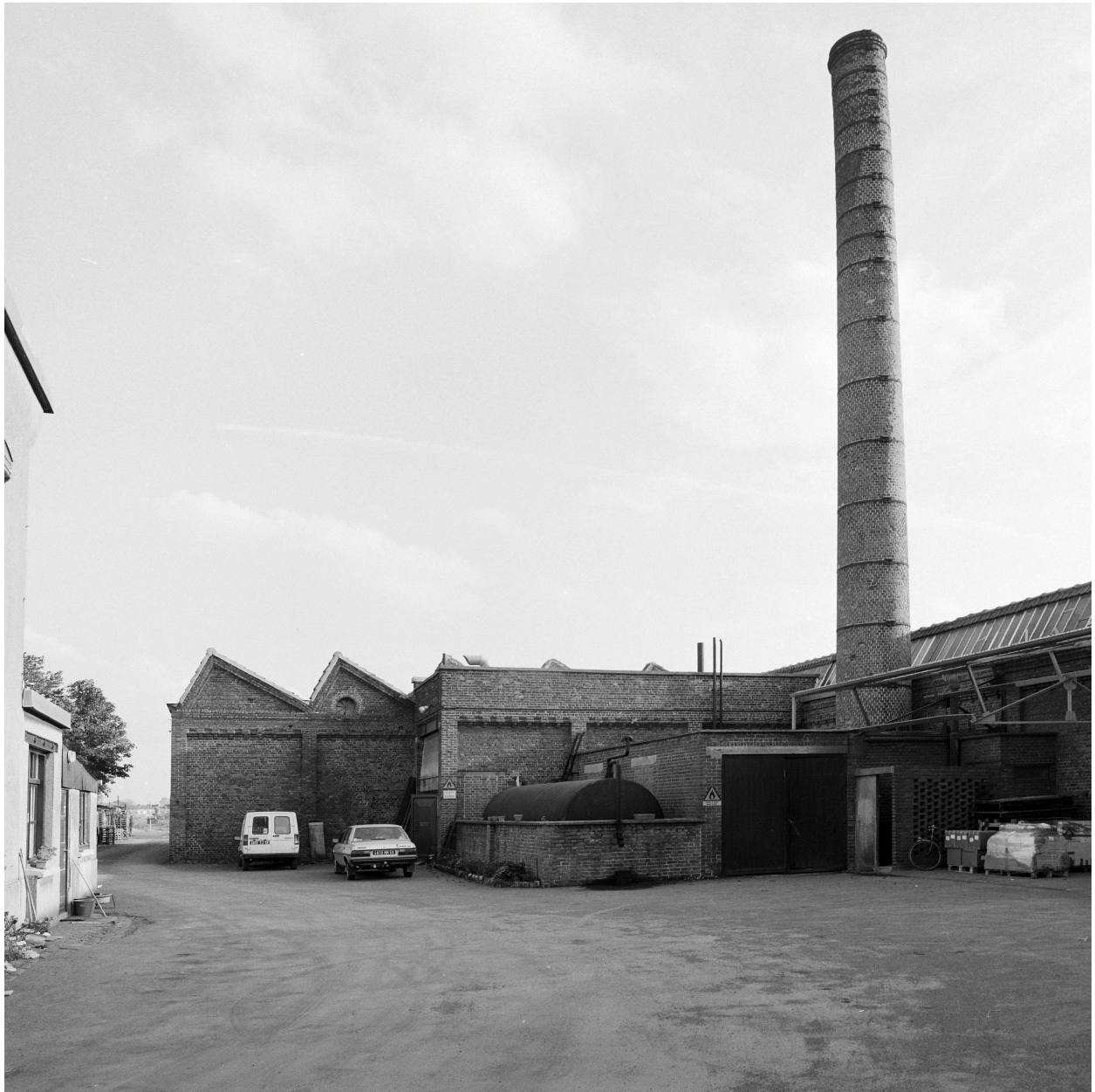
Atelier de fabrication depuis l'entrée.
