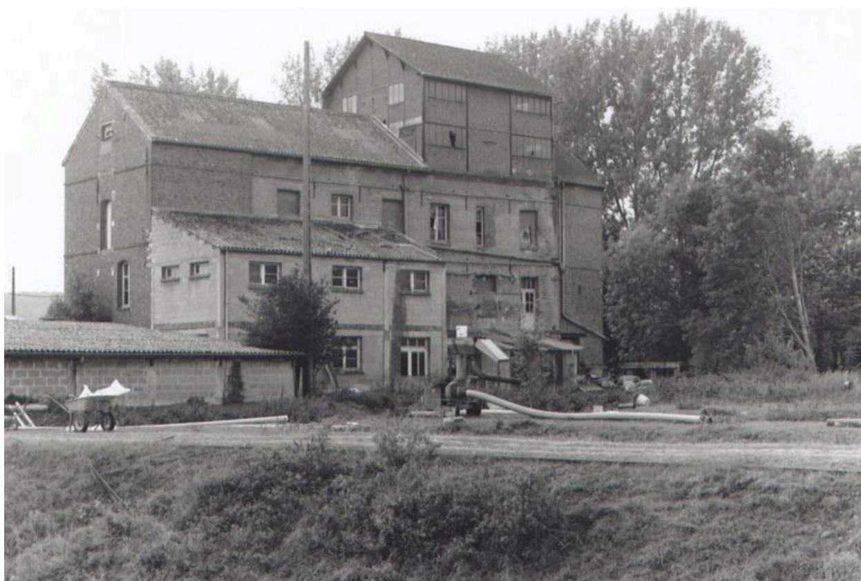
Ensemble postérieur de la minoterie.
