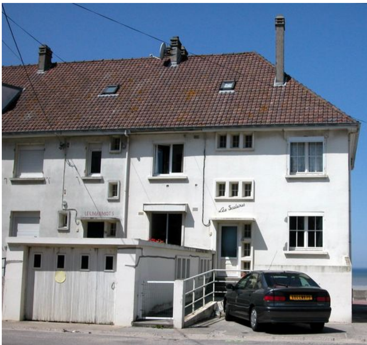
182 boulevard maritime sud (Les Scalaires), façade d'entrée.
