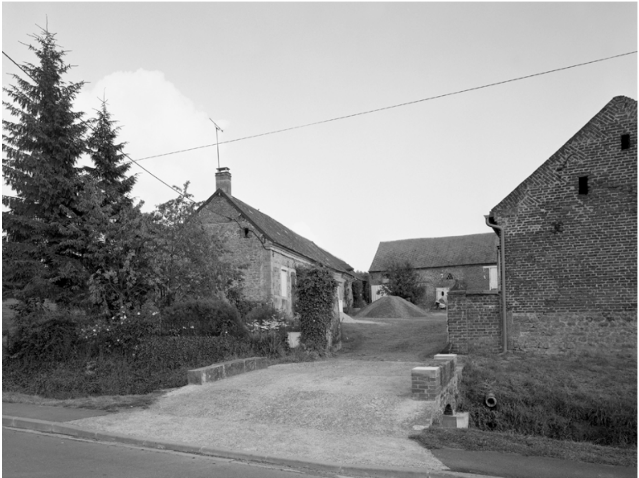
Boué, ferme (étudiée), 26 rue des Vannois.
