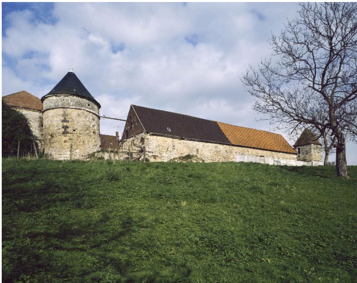
Vue de l'élévation externe de l'aile sud-ouest.
