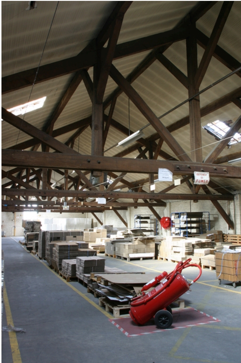
Charpente des ateliers restaurés en 1919.
