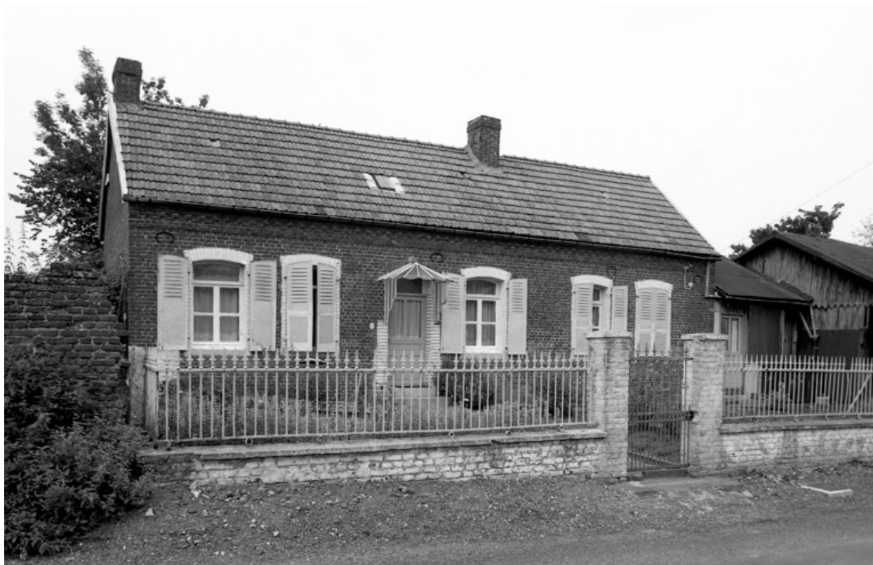
Vue d'ensemble de la façade.
