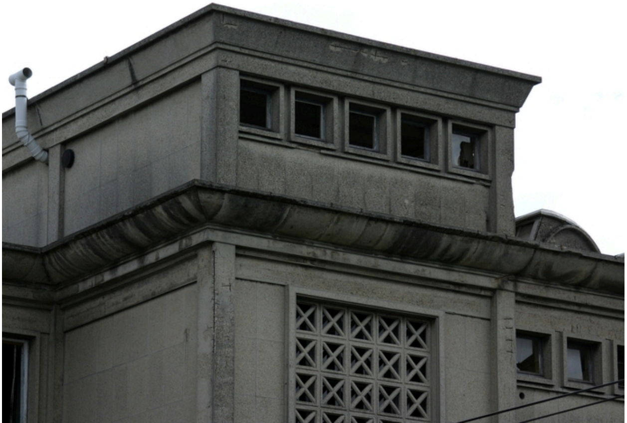
Détail de la façade antérieure des services généraux.
