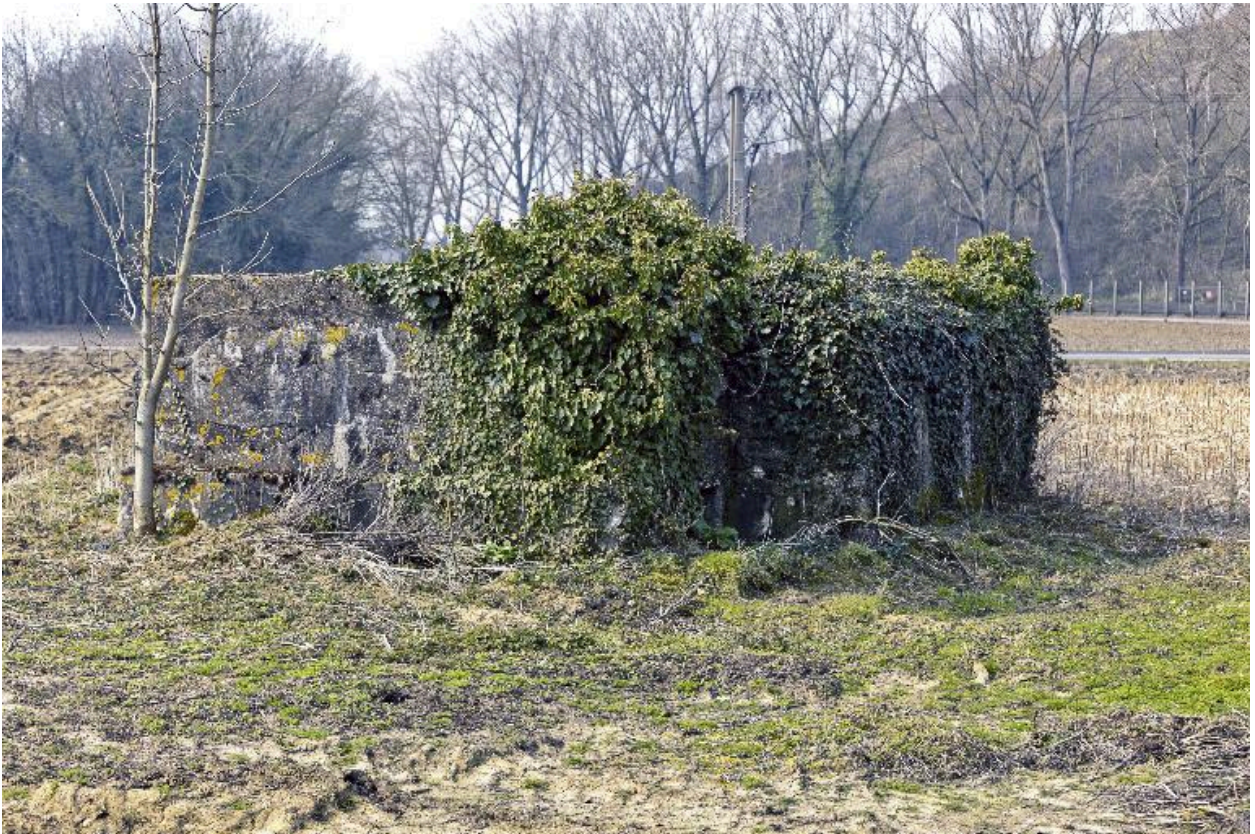
Vue générale vers le sud-ouest
