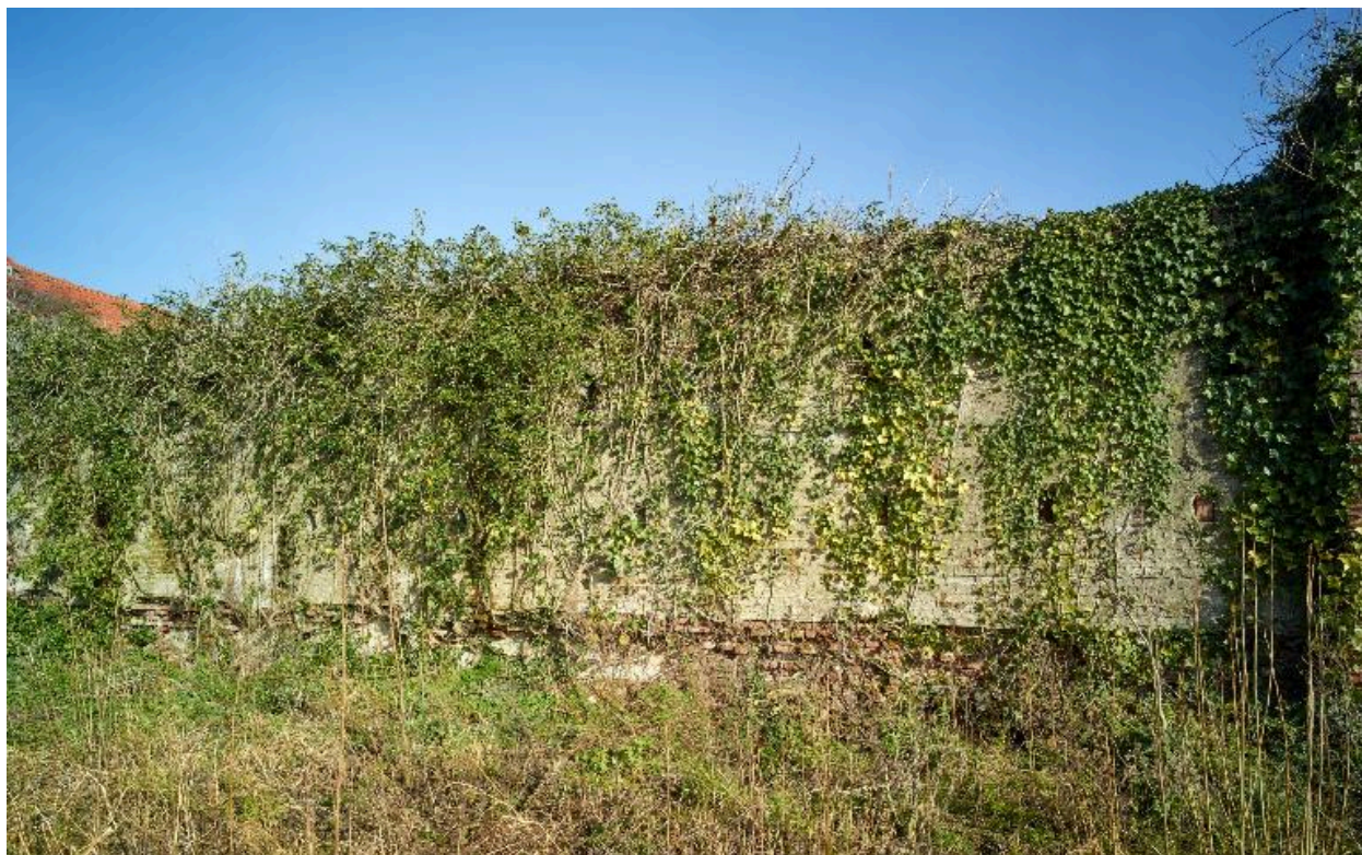
Elévation ouest de la ferme, créneaux de fusillade.
