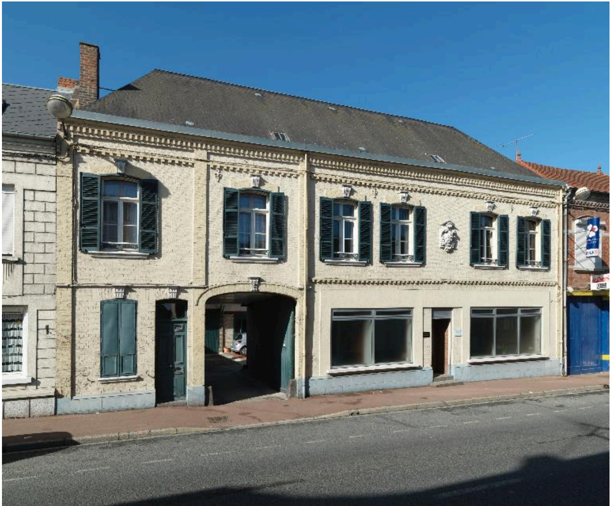
Immeuble sur rue (62, rue Roger-Godard).
