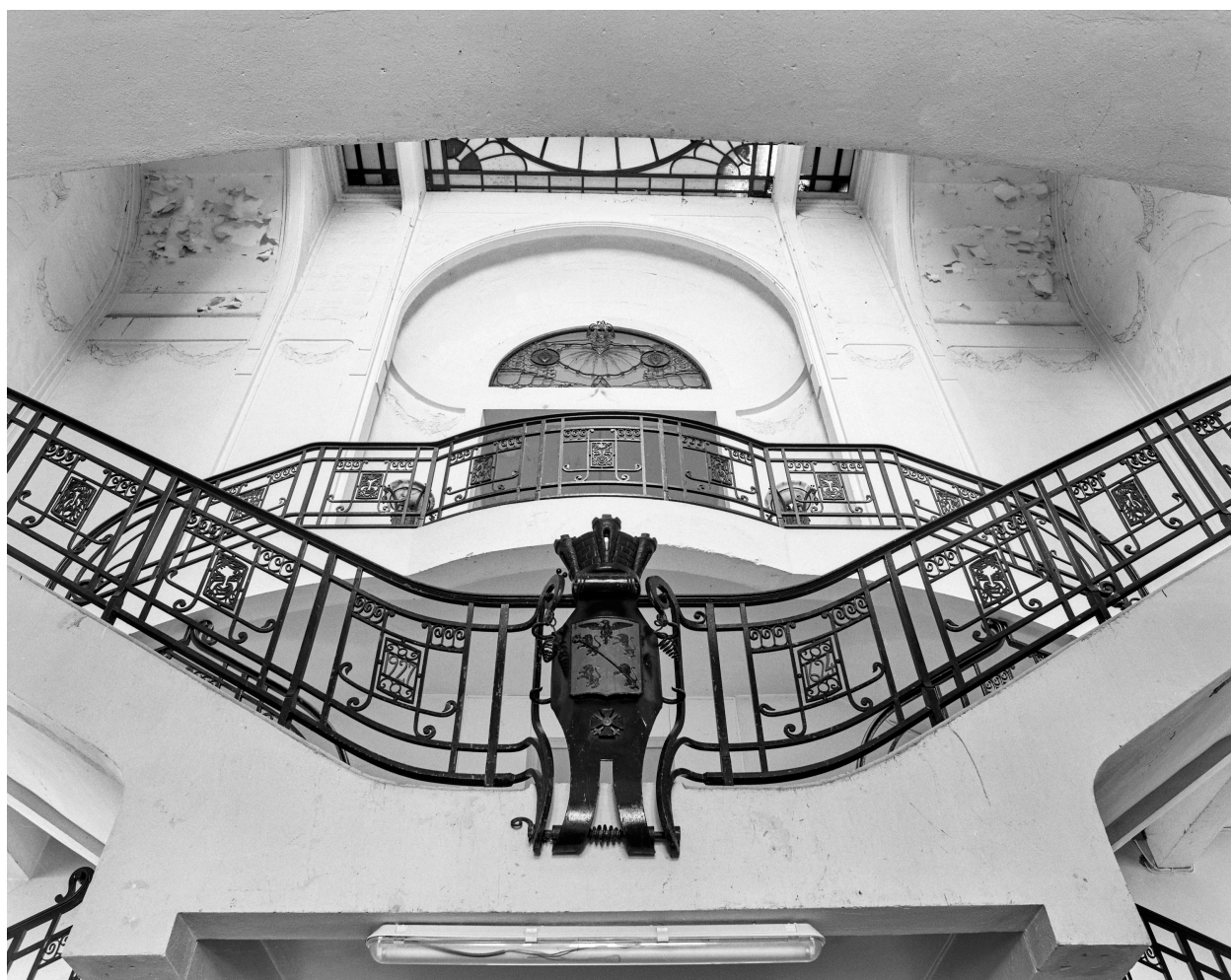
Vue générale du décor de ferronnerie du hall : rampe d'escalier (dates de construction (1624, 1927), la tragédie et la comédie) et tympan au-dessus de l'entrée de la salle de bal (danseuse saluant le public).
