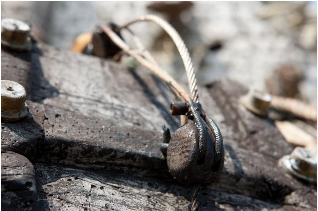
Détail de l'installation.
