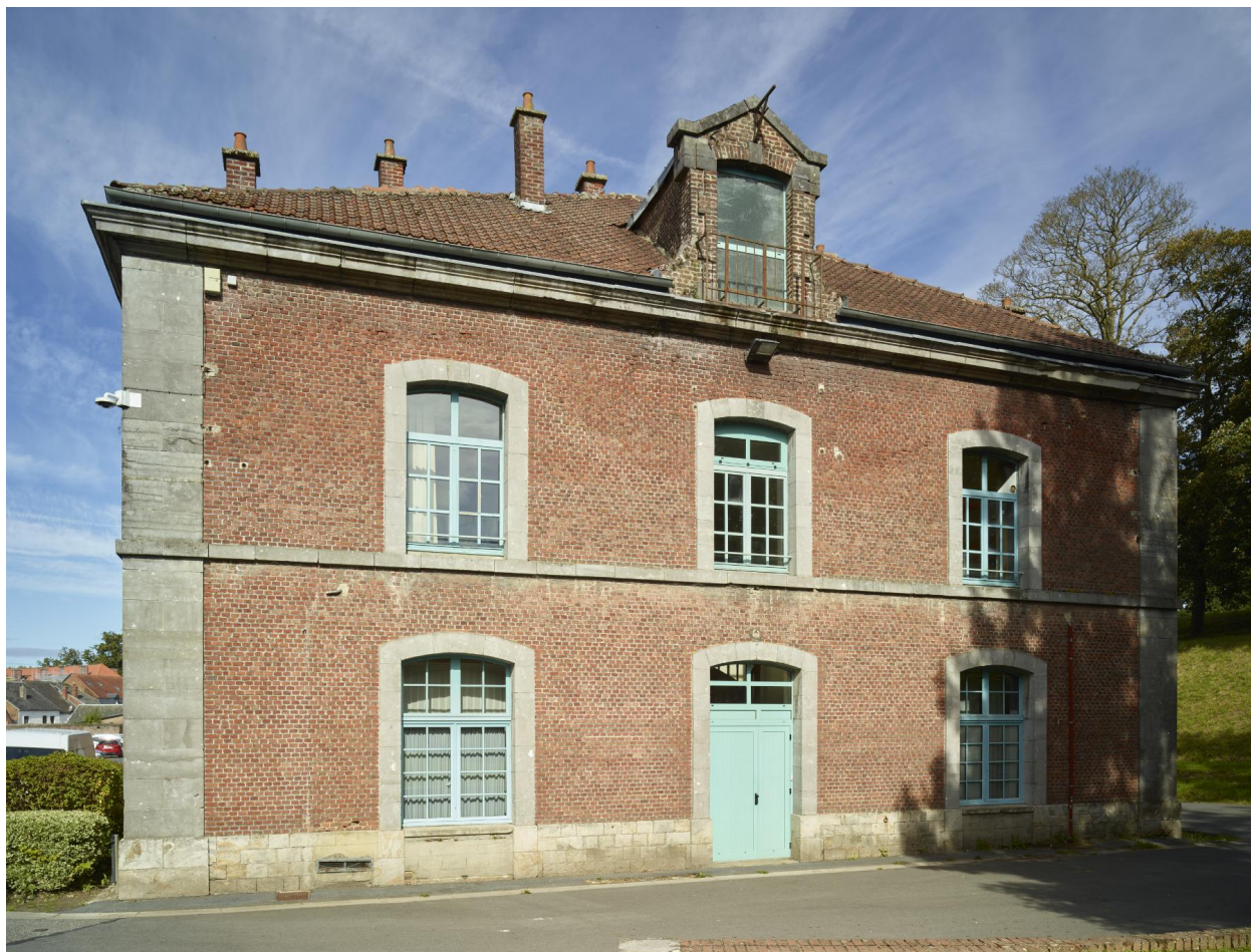
Ancienne caserne Lowendal : extrémité sud du bâtiment.
