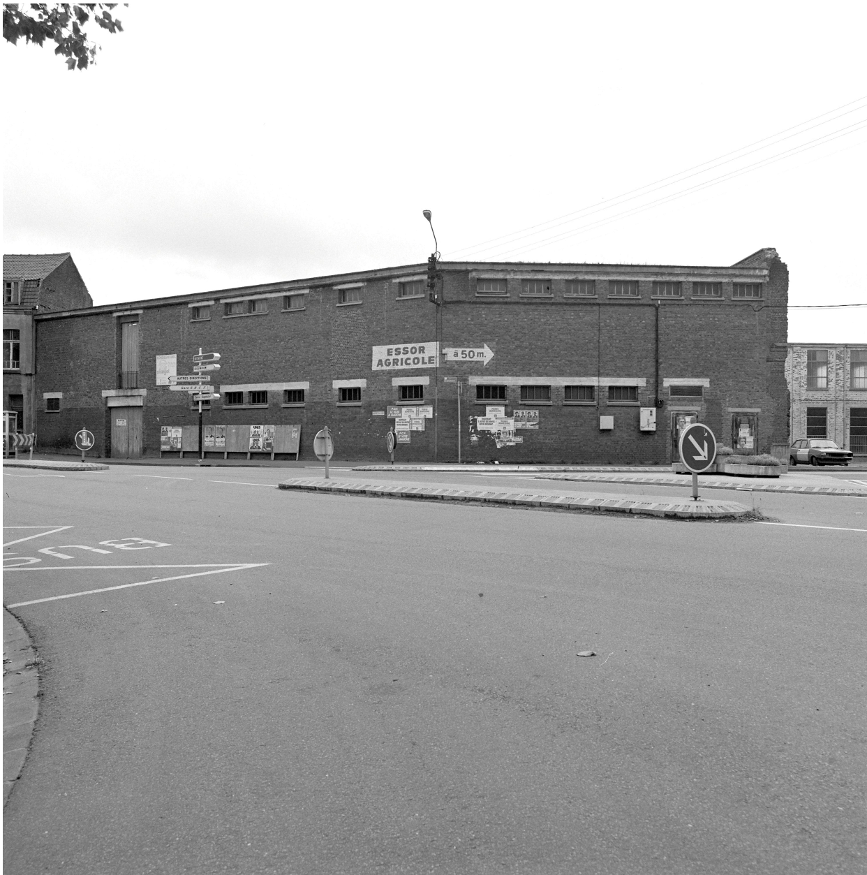
Atelier de fabrication, angle avec le boulevard Faidherbe.
